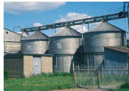
Abbildung 3: Wellblechsilos haben einen 3-4 cm breiten Luftspalt zwischen Wand und Silodach, sind aber auch zwischen den Blechen oft nicht gasdicht, weil Dichtungsgummis im Laufe der Jahre porös und rissig werden oder ganz fehlen
